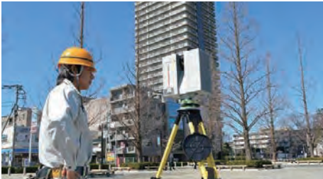
レーザースキャナー計測 作業風景
